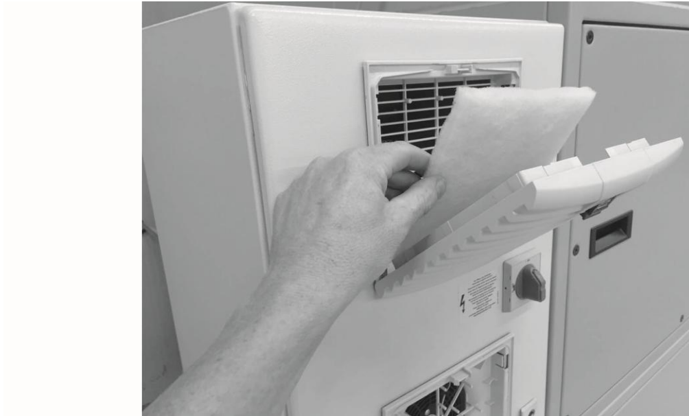
Kuva 39: Kytkenäkaapin suodattimen vaihto
